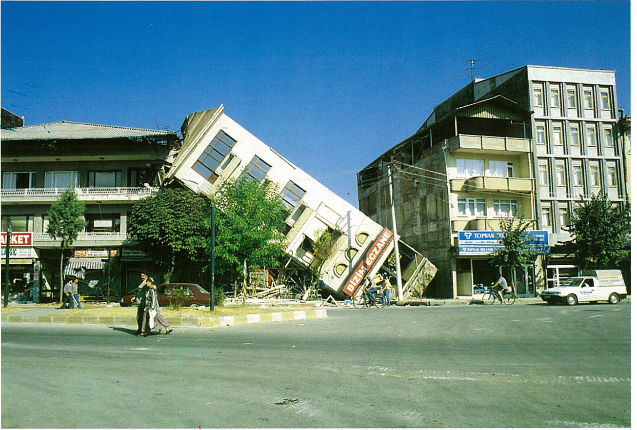
17 Ağustos 1999 Depremi sırasında sivilaşma sonucu oluşmuş yapı hasarı, Adapazarı İl Merkezi (Fotograf: Hamdi Mengi)
